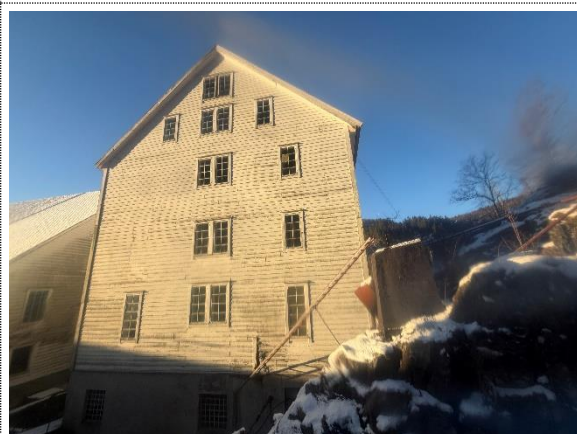
Bilde nr. 2.06 Fasade øst
