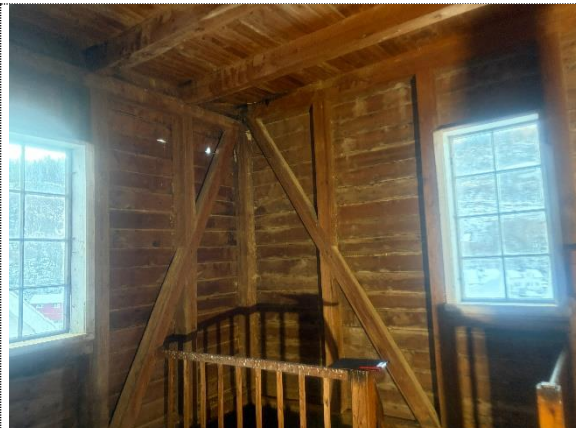
Bilde nr. 2.46 Fuktskader og hull på innvendig side av kledning i 5. etasje
