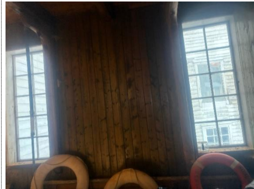
Bilde nr. 2.52 Fuktskadet treoverflate i 3. etasje
