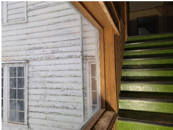
Bilde nr. 2.25 Nytt vindu med råteskadet føringer i kjeller
