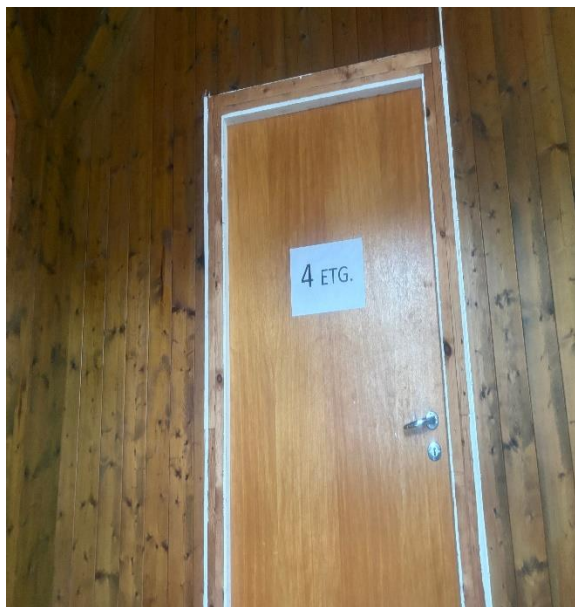
Bilde nr. 2.29 Eldre tredør i 4. etasje fra 1970-tallet
