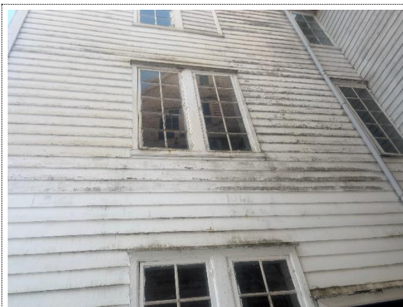
Bilde nr. 2.34 Vannbrett med råteskade ovenfor vindu
