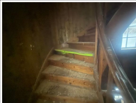
Bilde nr. 2.84 Fuktskader under trapp
