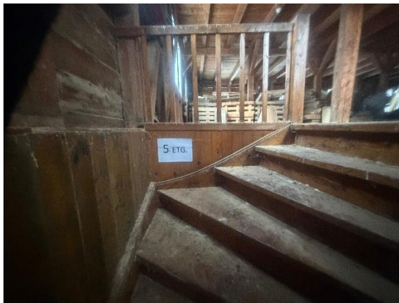
Bilde nr. 2.87 Trapp mellom 4. etasje og 5. etasje
