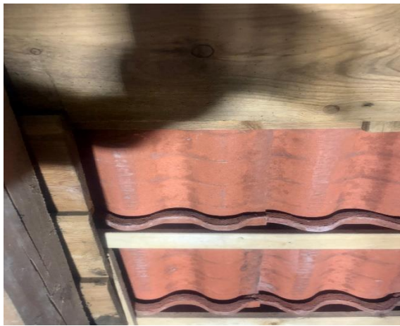
Bilde nr. 2.75 Ingen tegn til undertaksbelegg
