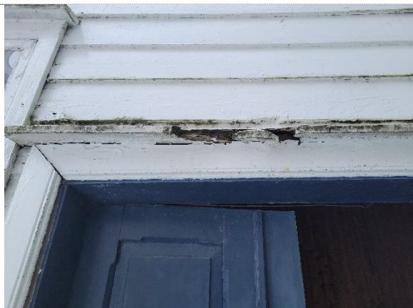
Bilde nr. 2.33 Vannbrett med råteskade ovenfor dør
