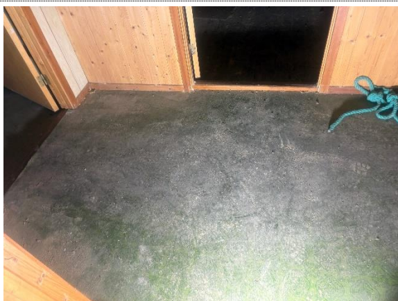
Bilde nr. 2.67 Grønt gulvbelegg
