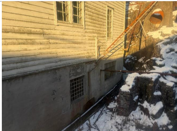
Bilde nr. 2.07 Grunnmur av pusset teglstein
