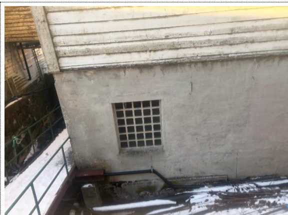
Bilde nr. 2.08 Støp av betong mot mark, kun registrert i området ved bekk.
