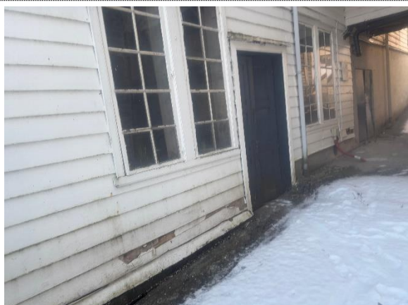
Bilde nr. 2.33 Vannbrett med råteskade ovenfor dør
