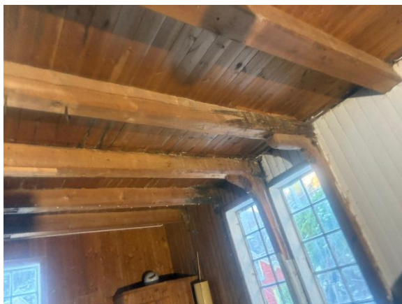
Bilde nr. 2.13 Råteskader på bjelker i 3. etasje
