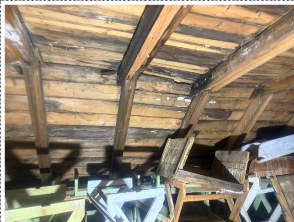
Bilde nr. 2.72 Himlingsplater i etasje 4 med fuktskader og avskallet maling.
