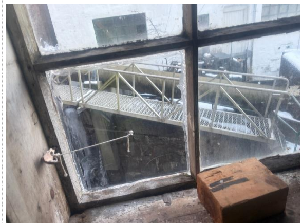
Bilde nr. 2.22 Vindu med enkeltglass og sprosser med råteskader på karm
