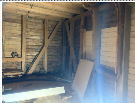
Bilde nr. 2.42 Råteskader og nedbrytning av trevirke på innvendig side.
