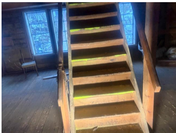
Bilde nr. 2.89 Trapp til 7. etasje, loft.
