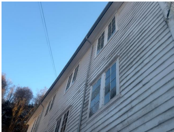
Bilde nr. 2.75 Ingen tegn til undertaksbelegg
