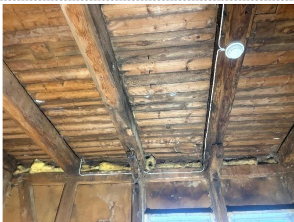
Bilde nr. 2.13 Råteskader på bjelker i 3. etasje
