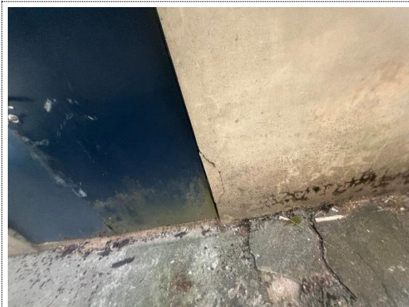
Bilde nr. 2.36 Begroing og råteskader på vest fasaden
