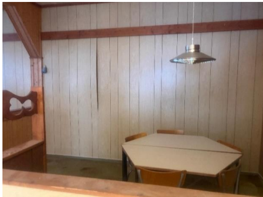
Bilde nr. 2.51 Fuktskadet veggoverflate i kjeller
