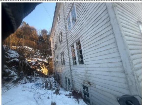
Bilde nr. 2.35 Råteskadet kledning sør-fasade.
