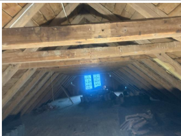
Bilde nr. 2.73 Oversikt loft 7. etasje
