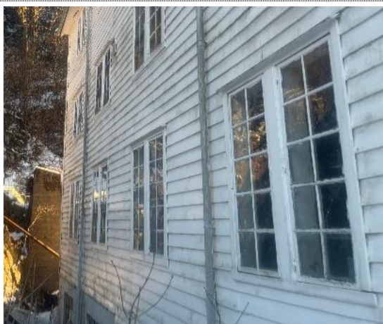
Bilde nr. 2.79 Taknedløp i stål
