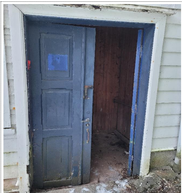
Bilde nr. 2.32 Utvendig tredør fra byggår
