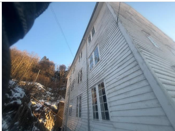
Bilde nr. 2.01 Fasade nord
