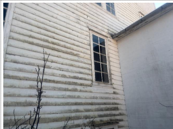
Bilde nr. 2.34 Vannbrett med råteskade ovenfor vindu
