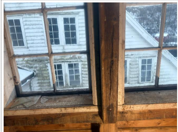
Bilde nr. 2.22 Vindu med enkeltglass og sprosser med råteskader på karm
