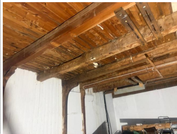
Bilde nr. 2.14 Råteskader på bjelker i 3. etasje
