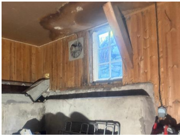
Bilde nr. 2.25 Nytt vindu med råteskadet føringer i kjeller
