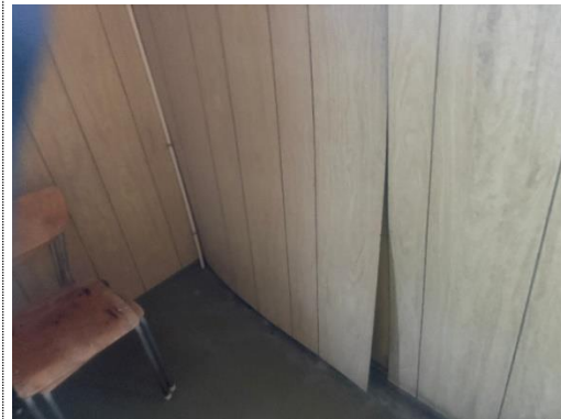
Bilde nr. 2.52 Fuktskadet treoverflate i 3. etasje
