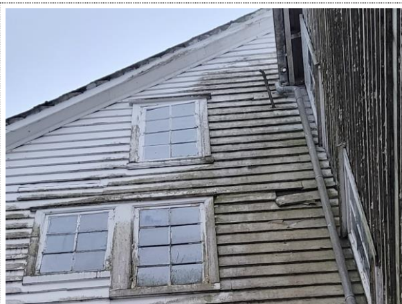
Bilde nr. 2.41 Utvendig kledning mot nord
