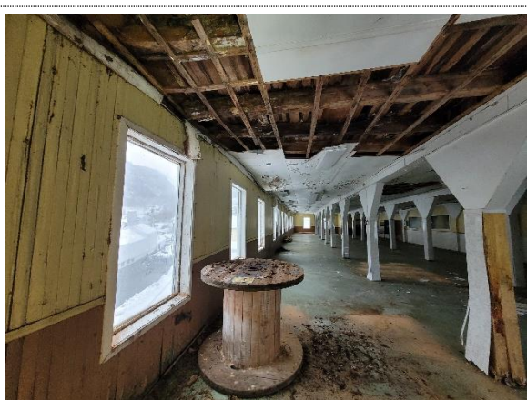
Bilde nr. 2.23 Opplegg på yttervegg i plan 3
