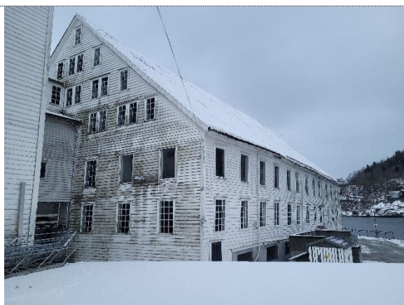
Bilde nr. 2.03 Fasade mot nordvest
