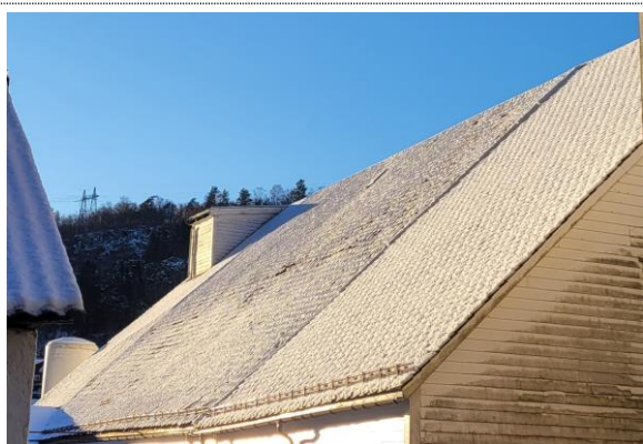
Bilde nr. 2.79 Snødekt tak med ujevnheter i takflate
