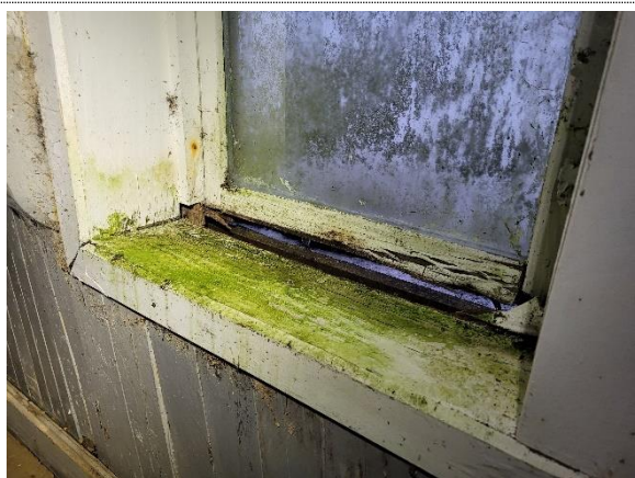
Bilde nr. 2.53 Fremskredet råte i karm og vegg på vindu i sidebygg mot vest
