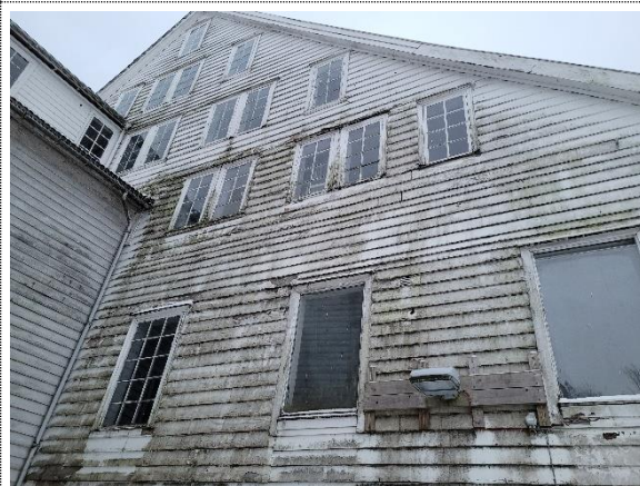
Bilde nr. 2.40 Utvendig kledning mot nord
