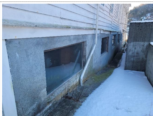
Bilde nr. 2.45 Vegg av pusset betongblokk
