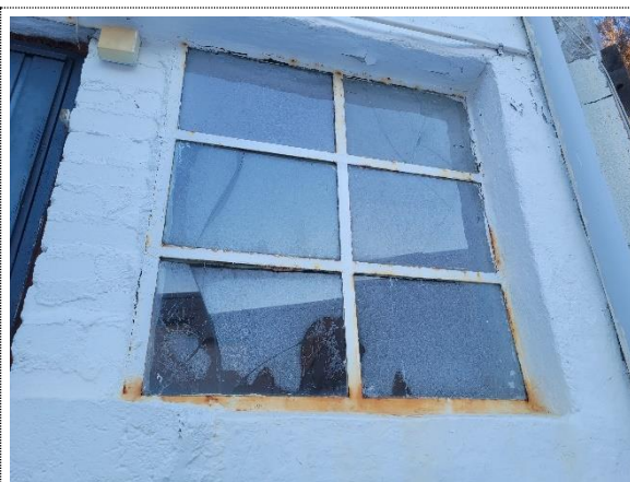
Bilde nr. 2.56 Jernvindu av enkelt glass
