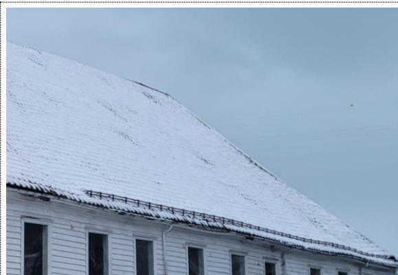
Bilde nr. 2.80 Snødekt tak med ujevnheter i takflate
