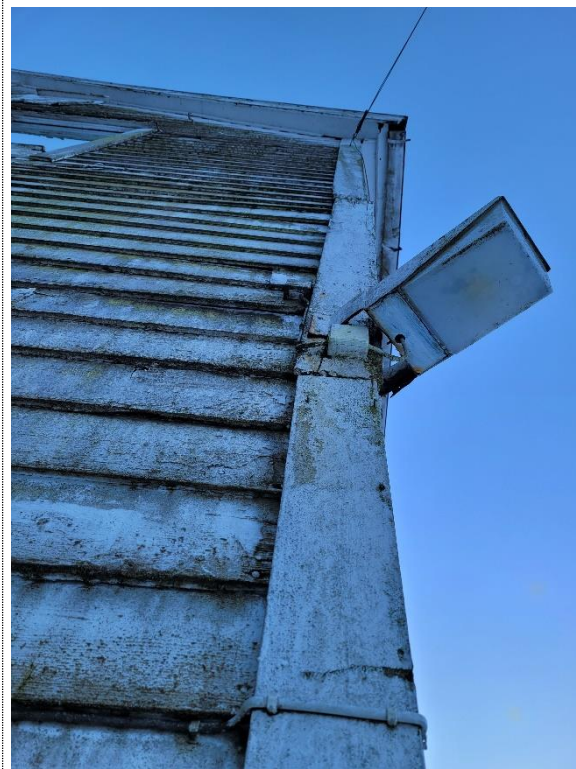
Bilde nr. 2.32 Synlige retningsavvik på fasaden
