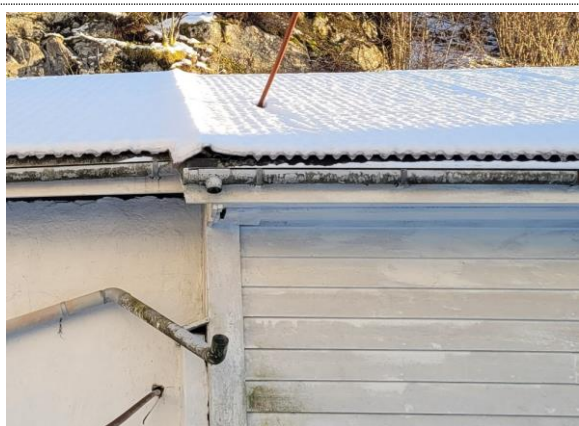
Bilde nr. 2.89 Løstnet taknedløp på sidebygg
