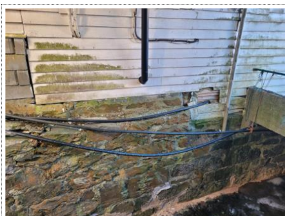
Bilde nr. 2.06 Natursteinsmur på nordside av bygg langs med tørrlagt elveløp
