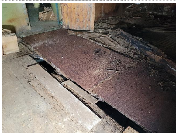
Bilde nr. 2.69 Tregulv supplert med stålplater i plan 3
