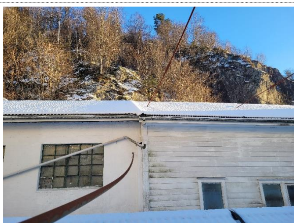
Bilde nr. 2.29 Strekkestag gjennom tak på sidebygg og inn i fjell
