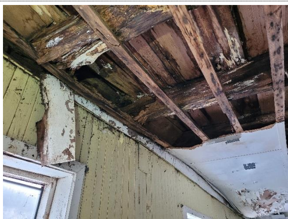
Bilde nr. 2.77 Avrotne bjelkeender i plan 3
