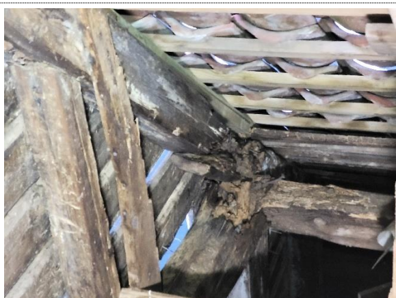
Bilde nr. 2.75 Knekt taksperre på gavl i plan 6
