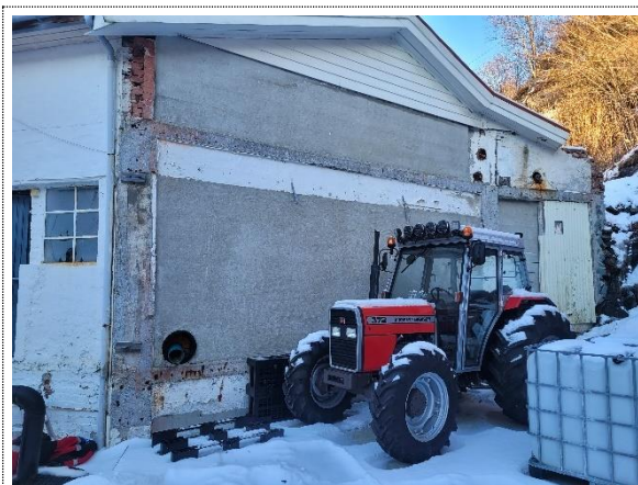
Bilde nr. 2.44 Yttervegg mot sør med spor etter revet bygg.
