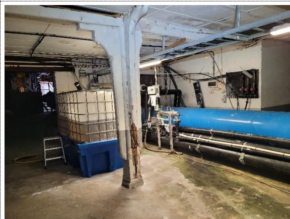
Bilde nr. 2.14 Stolpe med råteskade i plan 1
