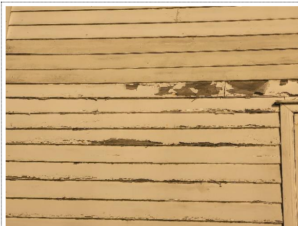
Bilde nr. 2.42 Utvendig kledning mot sør
