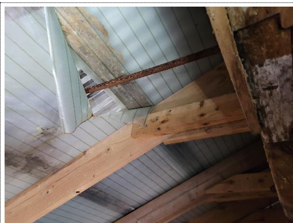
Bilde nr. 2.30 Strekkestag inne i bygget på sidebygg
