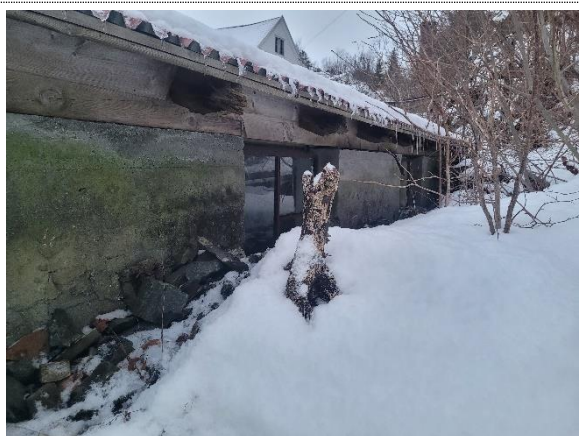
Bilde nr. 2.13 Terreng i høyde med vindu mot østfasade
