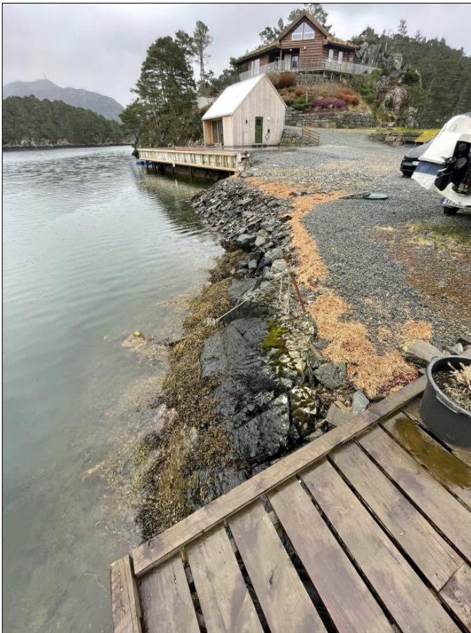
Figur 2-2 Ny kai og nytt naust på bnr. 89, april 2026. Del av kai foran bygg 44, jfr. fig. 2-1 over. Foto: Tiltakshaver
