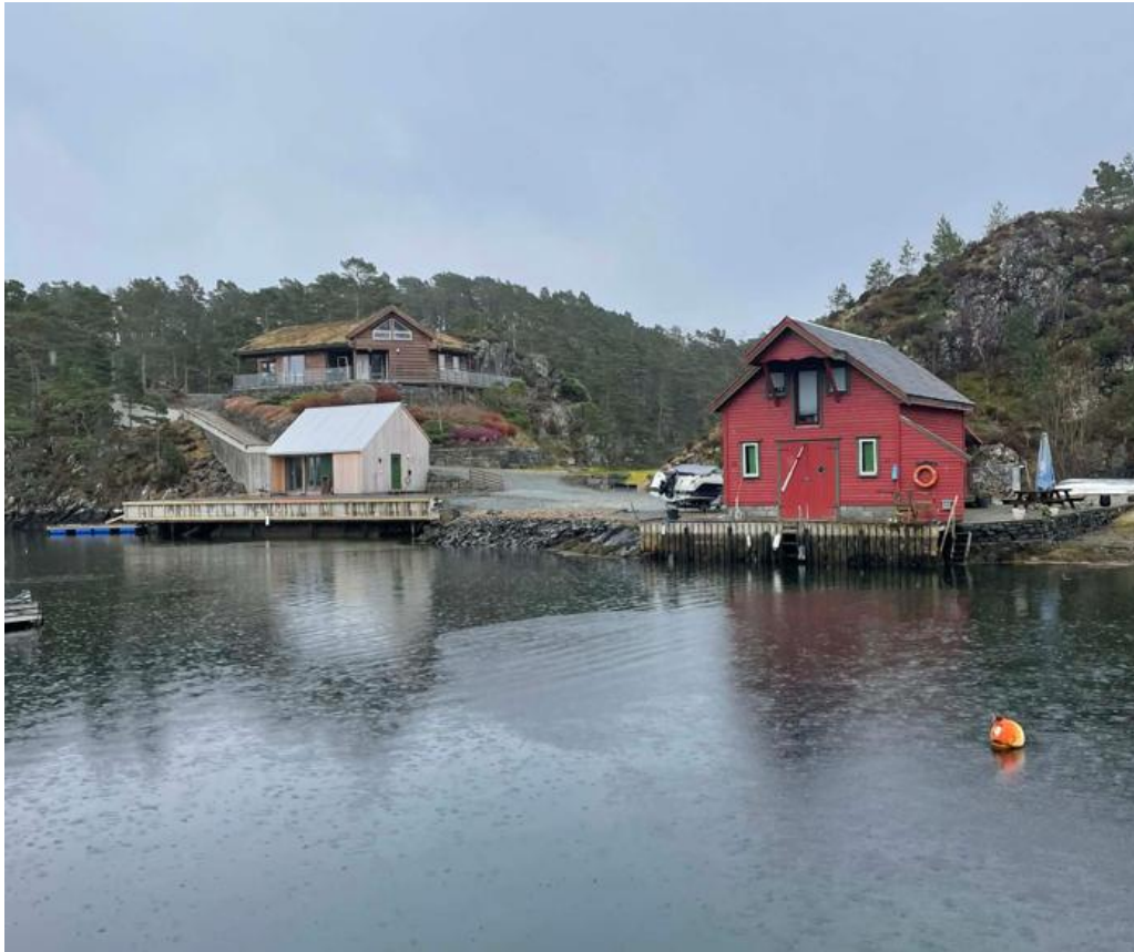
Figur 5: Oversikt over vika sett mot nausttomter gnr/bnr 4/271 og 4/272 og naboer rundt. Her ser vi et grusdekket område med fjell i dagen mot sjø. Sett fra kaien til gnr/bnr 4/146. Kaier typisk utbygd med påler.
