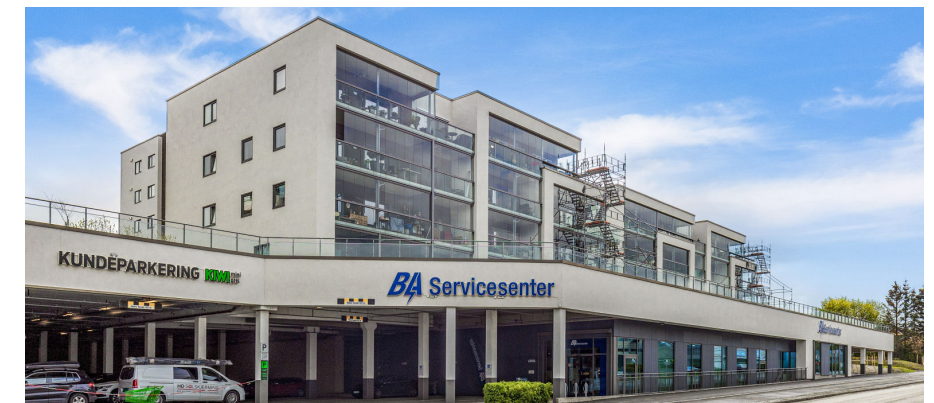
Strinda Hageby: nyere blokkbebyggelse
