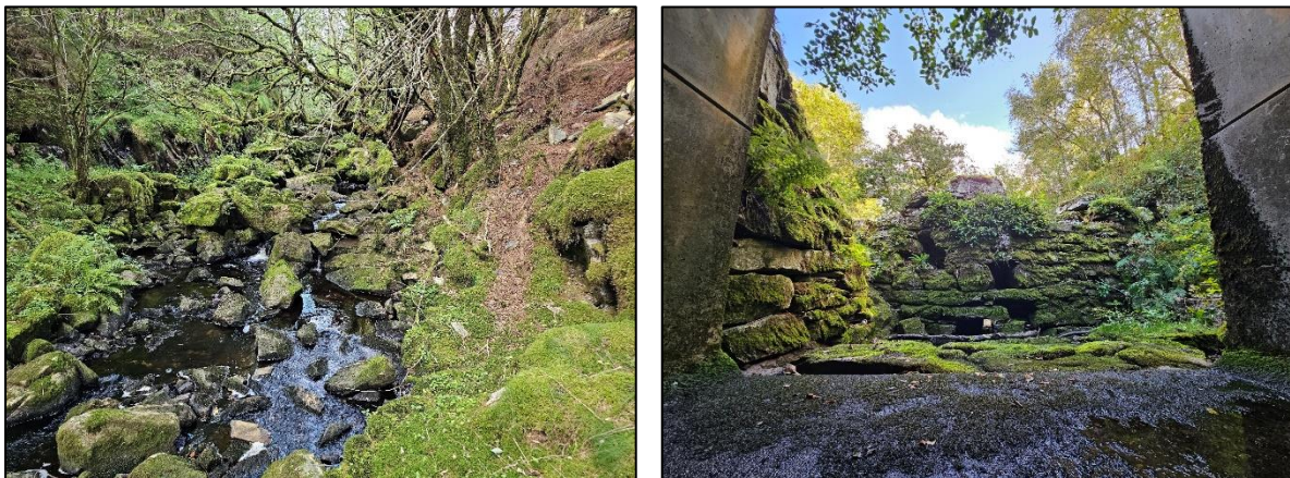
Figur 0-10 Fløksandselva sett mot nord mellom fylkesvegen og sjøen (t.v.) og vandringshinder (kulvert under fylkesvegen) sett mot sør (t.h.). Foto (20.08.2025): M. Bjerga, Multiconsult.
