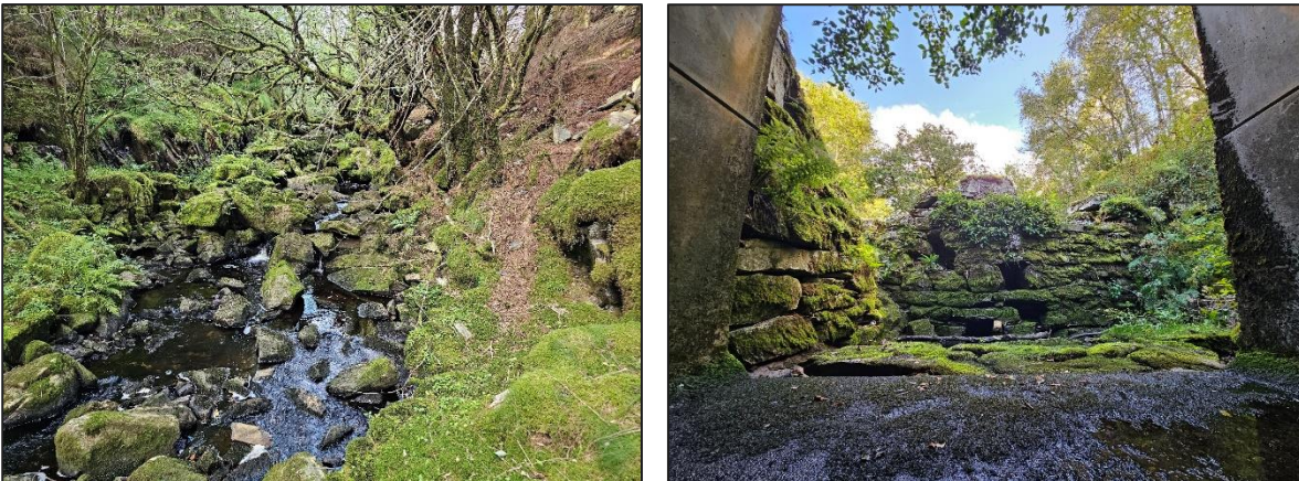
Figur 5-2 Fløksandselva sett mot nord mellom fylkesvegen og sjøen (t.v.) og vandringshinder (kulvert under fylkesvegen) sett mot sør (t.h.). Foto (20.08.2025): M. Bjerga, Multiconsult.
