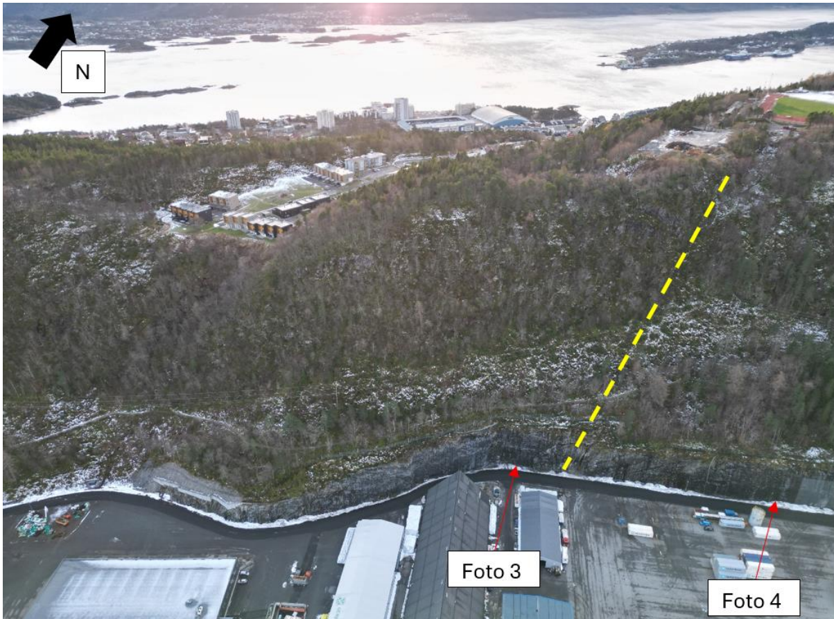
Foto 2 Detaljfoto bergskjæring saltlager. Rød pil markerer et potensielt påhugg vist i Foto 3. Gul stiplet linje markerer en topografisk forsinking (Multiconsult)
