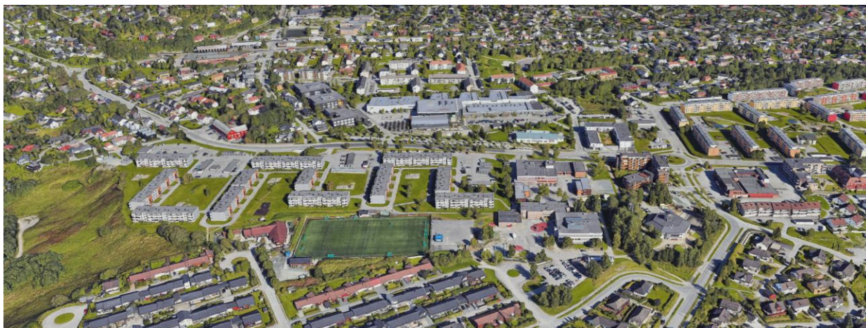
Fra GoogleEarth, fra før Migo-senteret ble revet.
