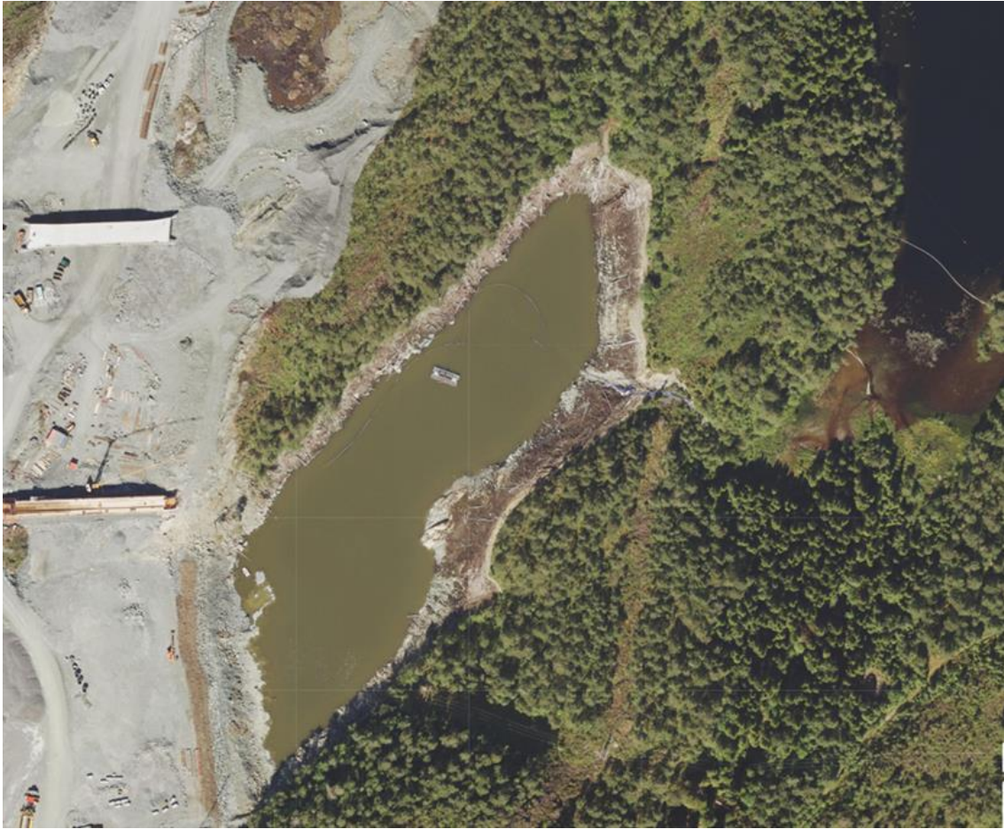
Figur 4-3 Anleggsarbeide ny E-39 (2027), nedtapping av Kvernatjørn. Siltgardin i Vinddalsvatnet ved utløpet av bekken fra Kvernatjørna. Kjelde: Bjørnafjorden kommune
