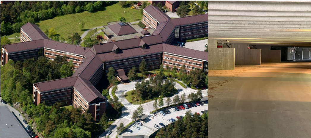
Sandslihaugen 30, parkeringsanlegget til høyre
