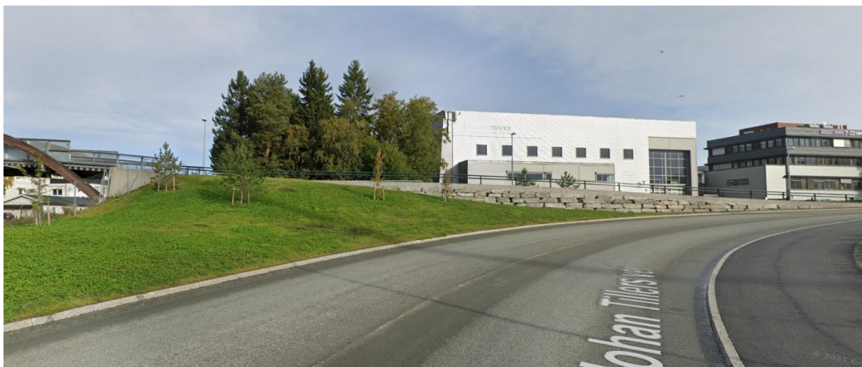
Figur 26 Eksisterende støttemur mellom G/S-veg og Johan Tillers vei (Bilde fra Google Maps street view)
