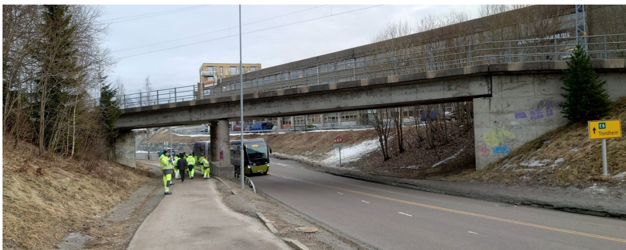
Figur 6 Heimdal bru sett fra sørvest (Befaringsbilde, Multiconsult)
