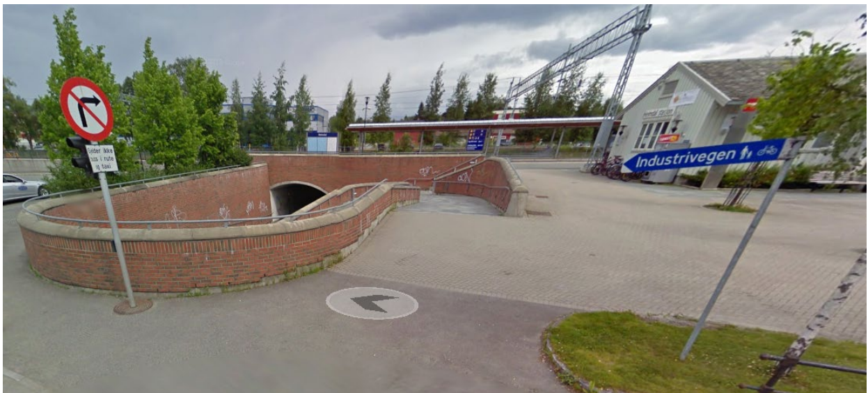
Figur 8 Eksisterende kulvert under stasjonen med adkomst til plattform og kryssing for gående og syklende fra Heimdalsvegen til Idrettsveien. (Bilde fra Google Maps street view)
