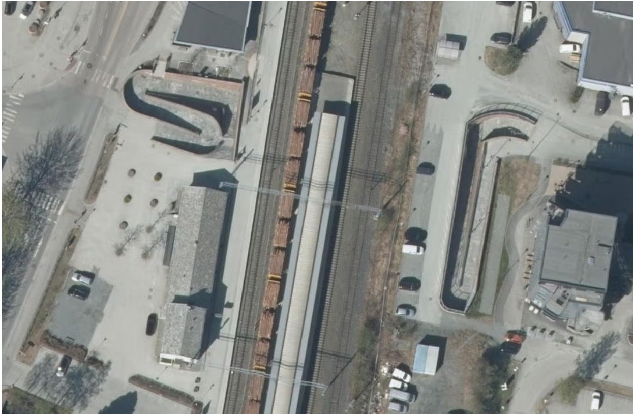
Figur 7 Eksisterende kulvert under stasjonen med adkomst til plattform og kryssing for gående og syklende fra Heimdalsvegen til Idrettsveien.
