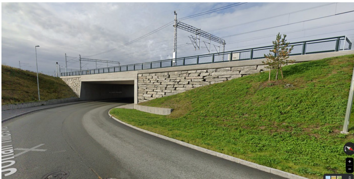
Figur 10 Kulvert Johan Tillers vei sett fra nordøst (Bilde fra Google Maps street view)
