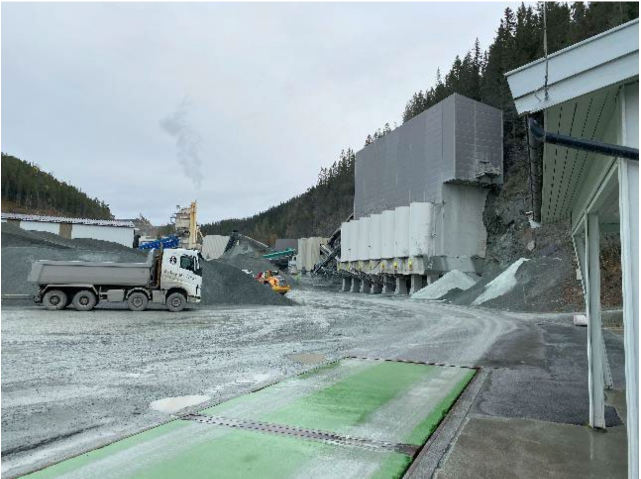
Figur 4-5: Dagens industriområde med lager-, trafikk-, knuse-/og sorteringsanlegg og administrasjonsbygg.
