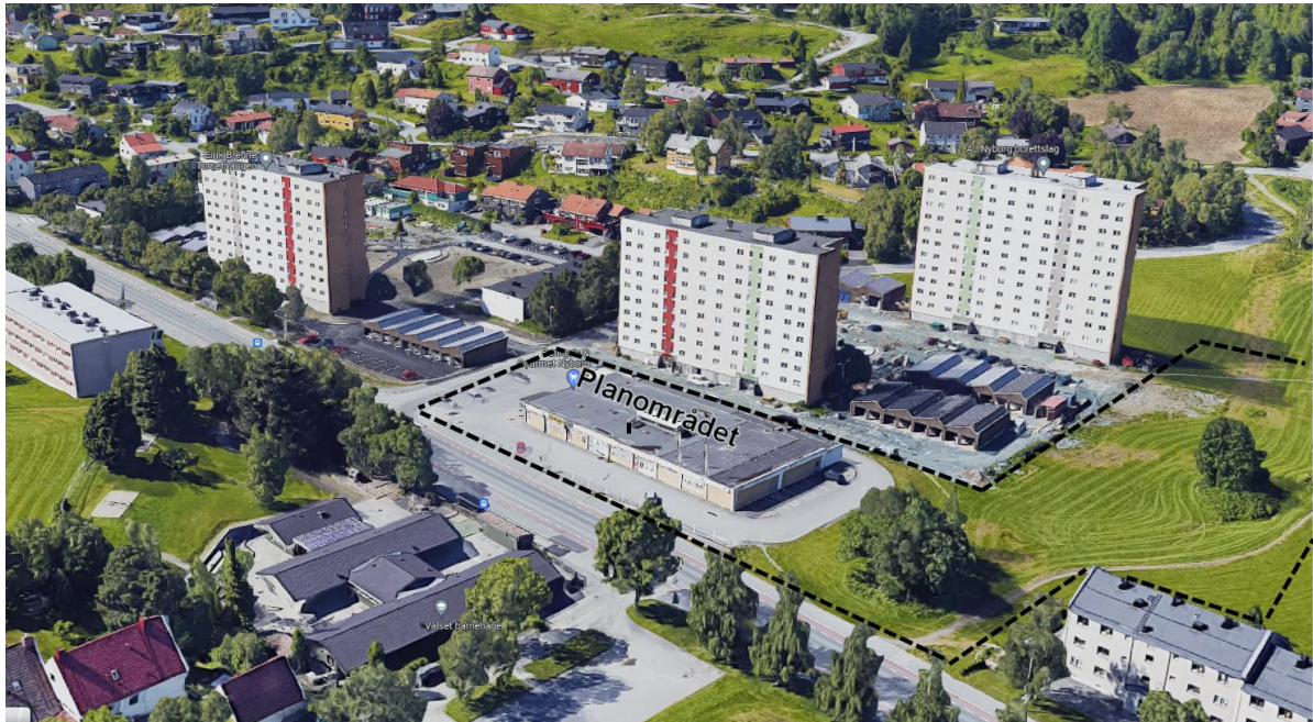
Figur 4-2 Utsnitt av området som viser blokkbebyggelsen ved planområdet. (Utsnitt hentet fra google maps, 2023)
