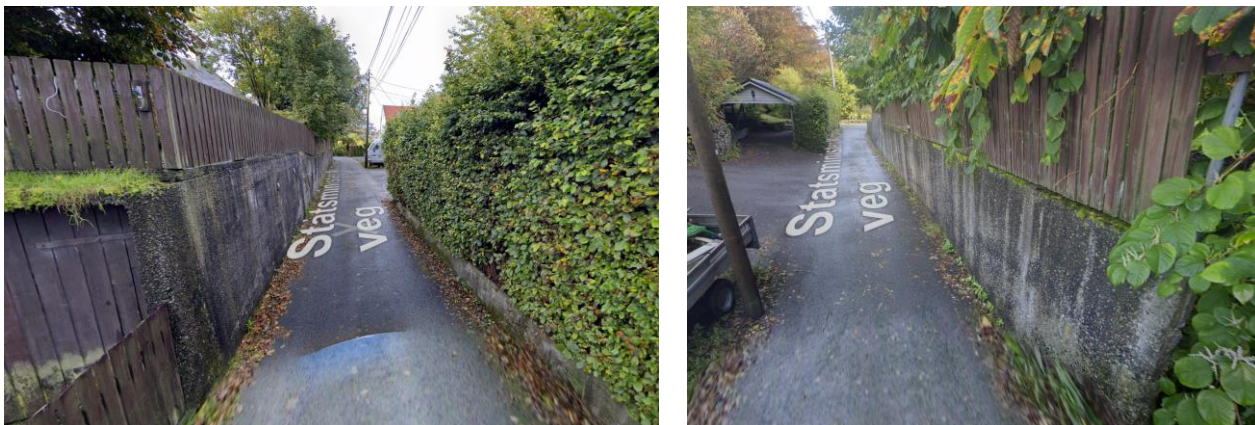
Figur 8 - Utklipp fra Google Maps som viser eksisterende mur.
