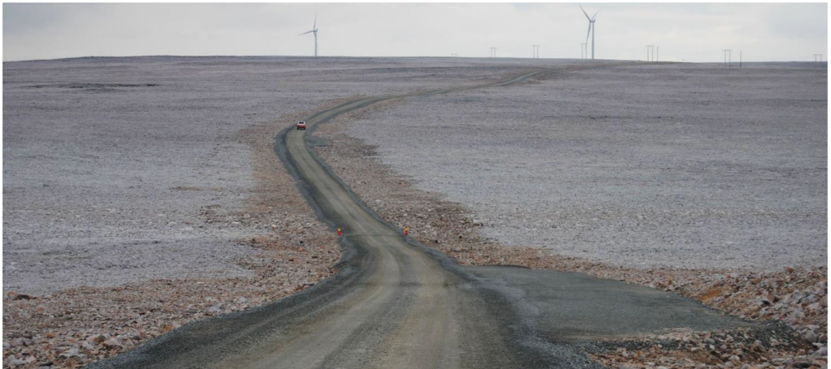
Figur 4-3: Adkomstvegen til Raggovidda vindkraftverk. Forholdene på Raggovidda og Davvi er veldig like, så bildet gir et godt inntrykk av hvordan adkomst-/internvegene på Davvi vil fremstå. Foto: Multiconsult Norge AS.
