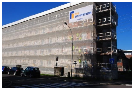
Figur 7: Stillasinndekning og stillaspresenning blir til mye avfall, selv om mye ombrukes flere ganger (foto: Eirik Wærner).
