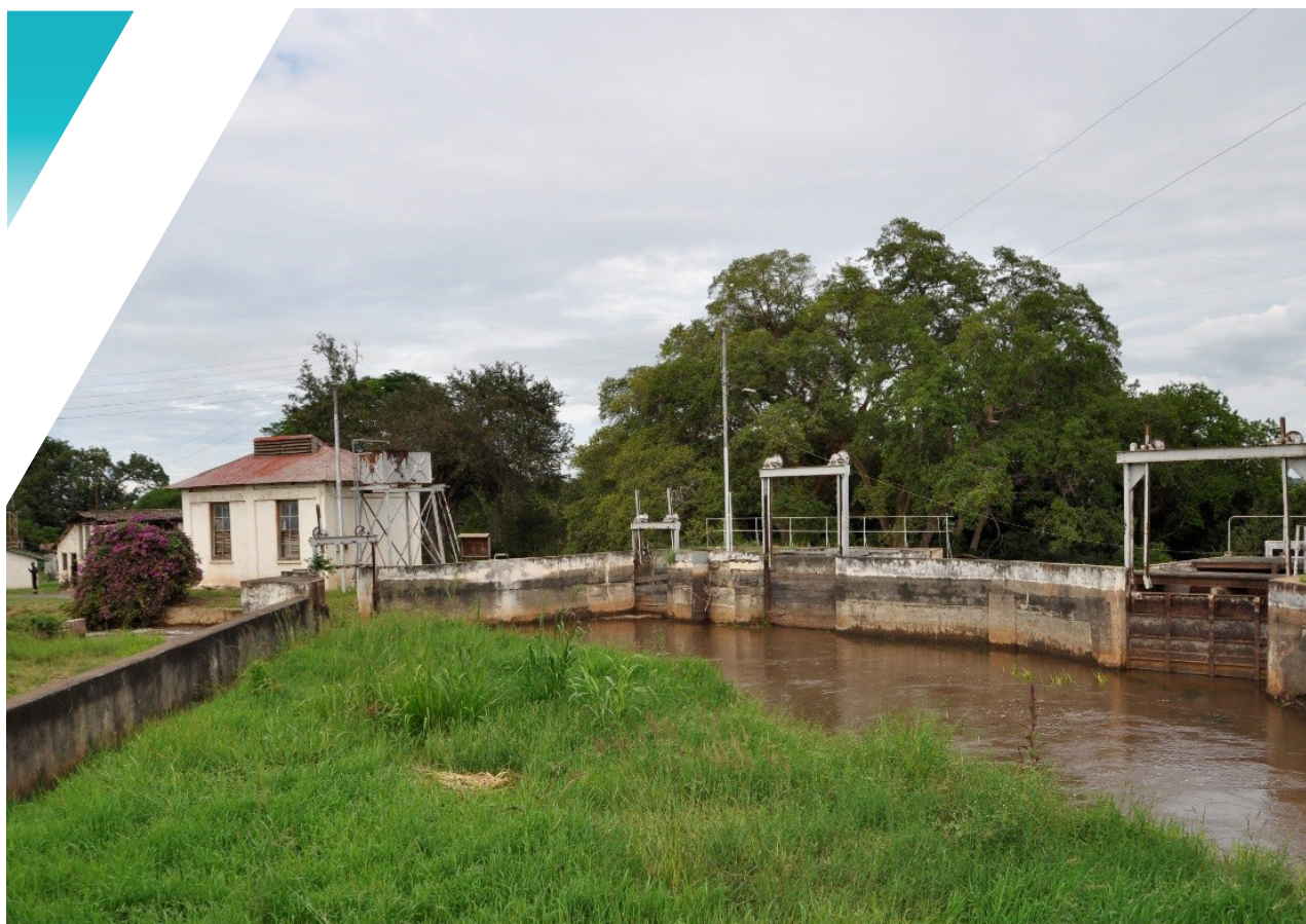
Inntaksbasseng ved den gamle kraftstasjonen | Foto: Jørn Stave, Multiconsult
