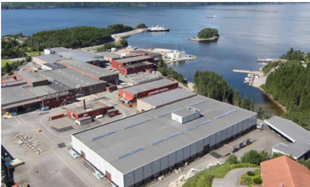
Nytt parkeringshus, rørlager og utvidelse industrihaller | Foto: Frank Mohn Fusa AS
