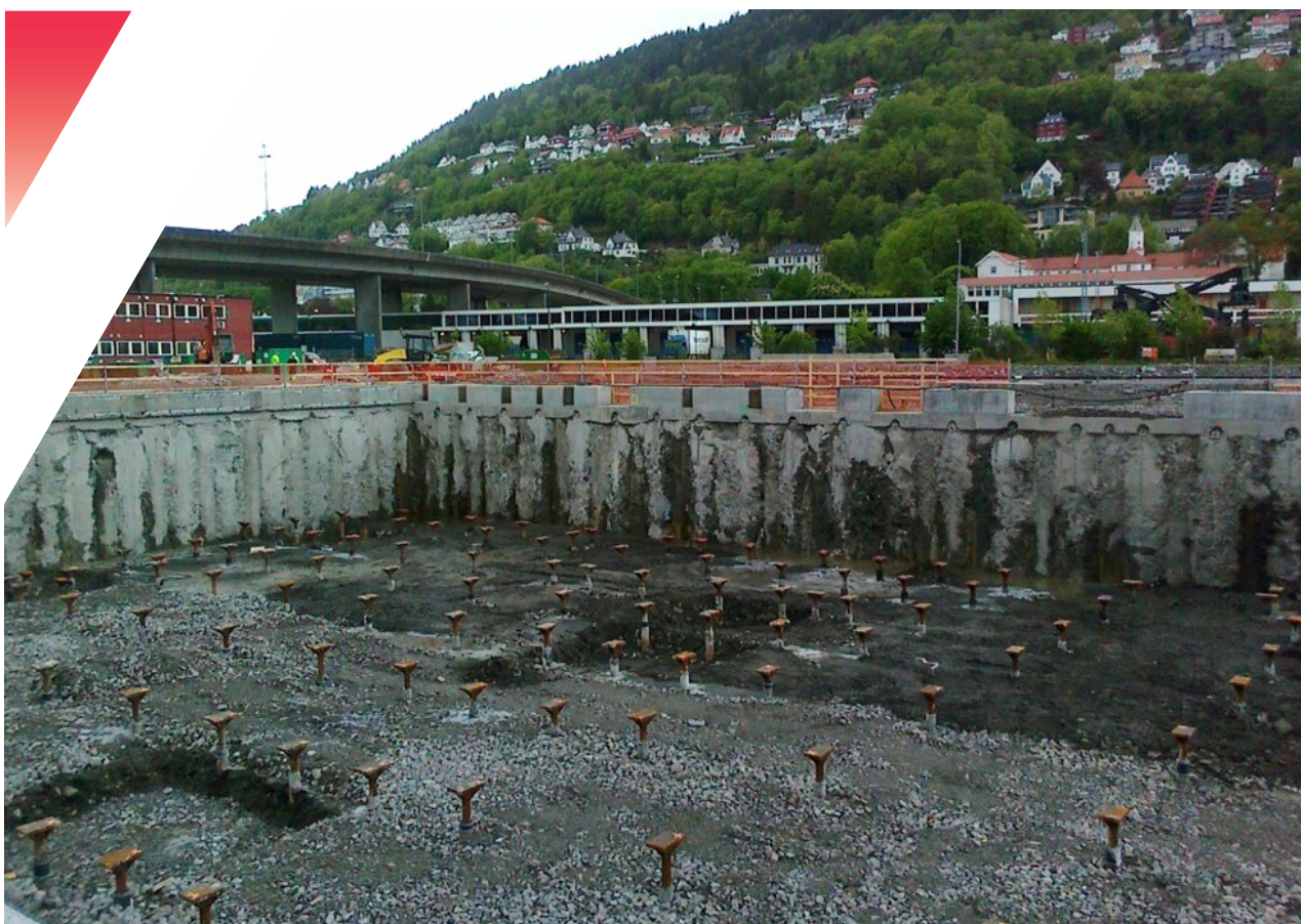
Ferdig byggegrøp for basseng | Foto: Multiconsult
