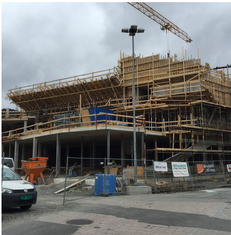
Fasade sør under bygging | Foto: Multiconsult
