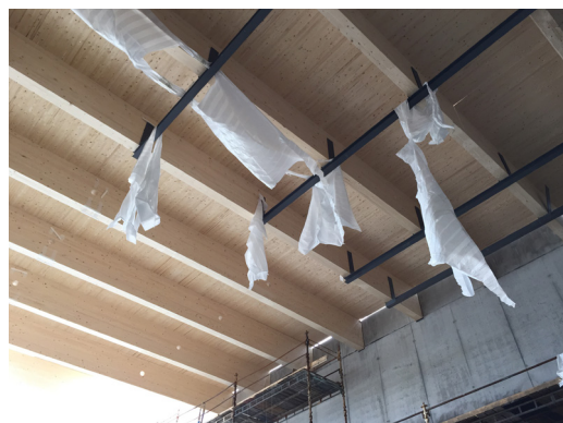
Øverst: Tegning fasade vest | Ill.: Helen & Hard Nederst: Massivtretek under bygging | Foto: Multiconsult
