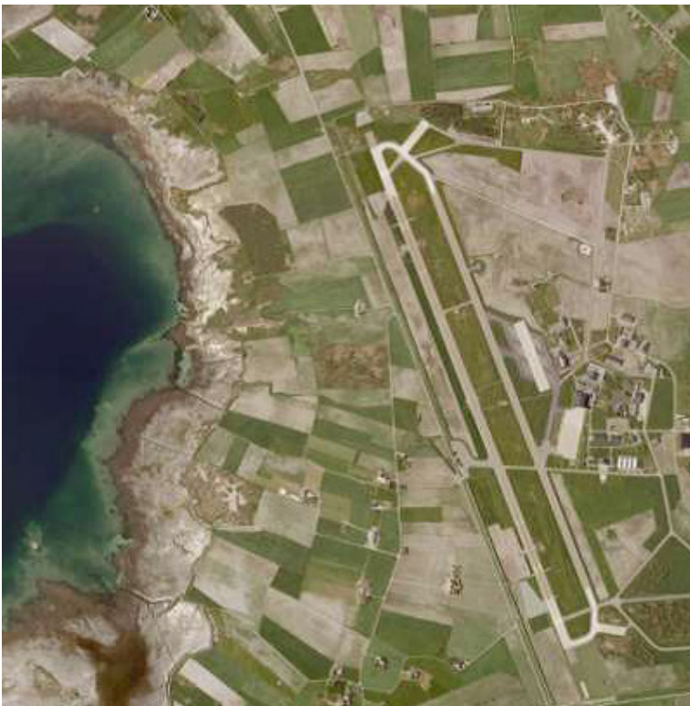
Ørlandet Flystasjon | Foto: Statkraft
